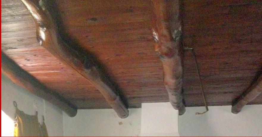
Balkendecke im Gräserhaus
